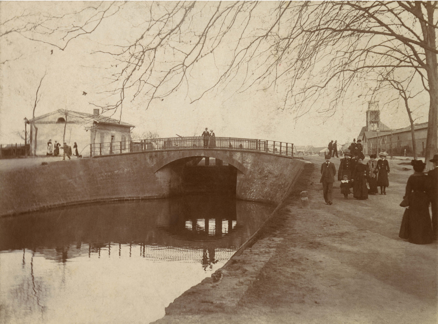
Fin XIX - Cliché du pont du Béarnais avec en premier plan la promenade sur le chemin de contre-halage bv. de la Marquette (archives Municipales de Toulouse). Ce cliché montre la continuité entre les culées maçonnées du pont et le soutènement soutenant le chemin. Au bout de cette pente un quai maçonné avec une plateforme de chargement était aménagé (hors cadre).
