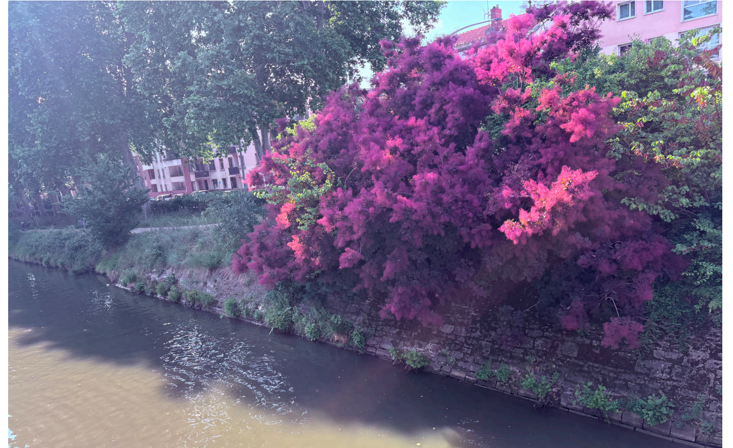
Vue générale de la berge opposée côté bv. de l'Embouchure. Malgré la colonisation végétale, l'ancien perré fin XVIIIe-début XIXe est encore en place et en état passable. La berge de ce côté est bien plus stable. Elle n'a pas fait l'objet de remaniements pour aménager des quais comme la berge qui lui fait face.
