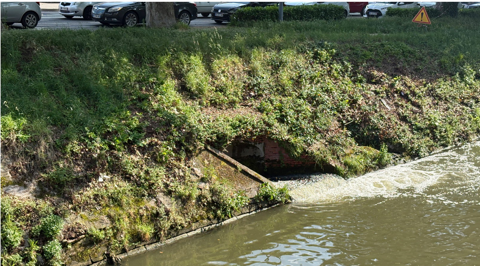
2. Vue de la dérivation aménagée à la fin des années 70 dans le mur préexistant.
