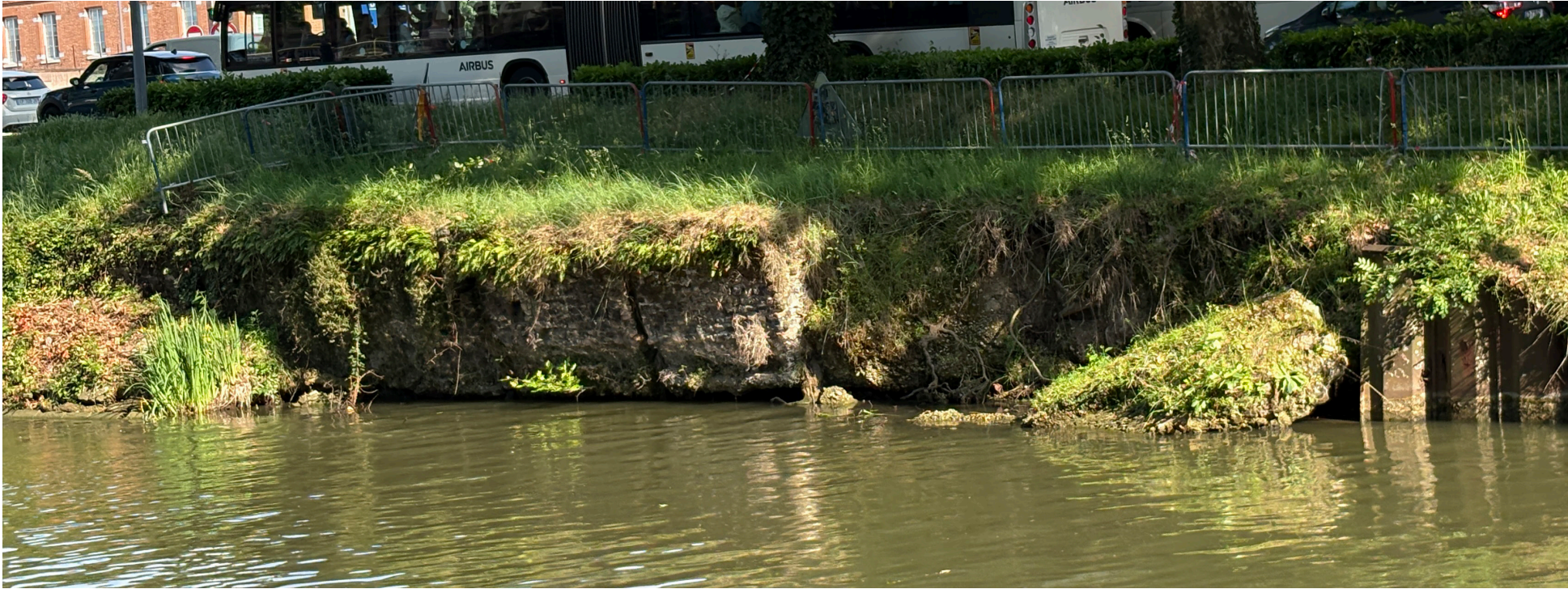
Vue de l'ancien quai de chargement dont les maçonneries sont en état de ruine - ravinement partiel, décollage, dévers, désolidarisation... Il s'agit de maçonneries peu qualitatives de tout venant car destinées à servir de support à un ponton en bois (les rainures de scellement des poteaux bois sont encore identifiables)
