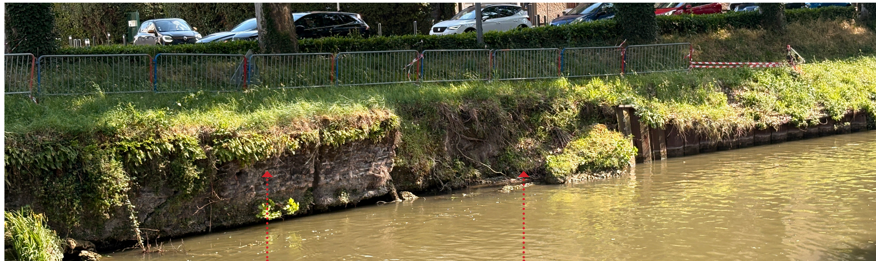
maçonnerie en dévers, fissurée et dé-jointoyée, basculement imminent
