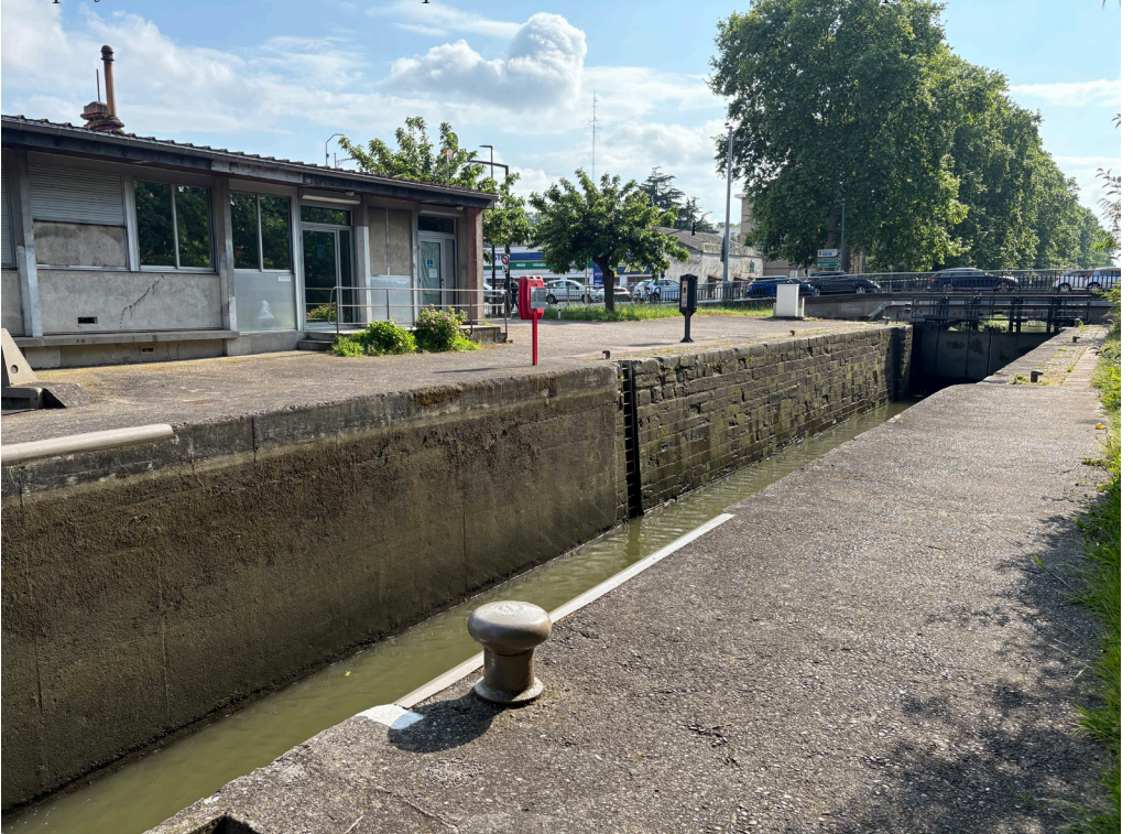
Vue du prolongement de l'écluse en béton lors de sa mise au gabarit Fressinet en 1978. Sur ce cliché on note également le poste de commande automatisé des écluses Toulousaines remplaçant la manœuvre mécanique de fonctionnement. Il est mis en place en 1968
