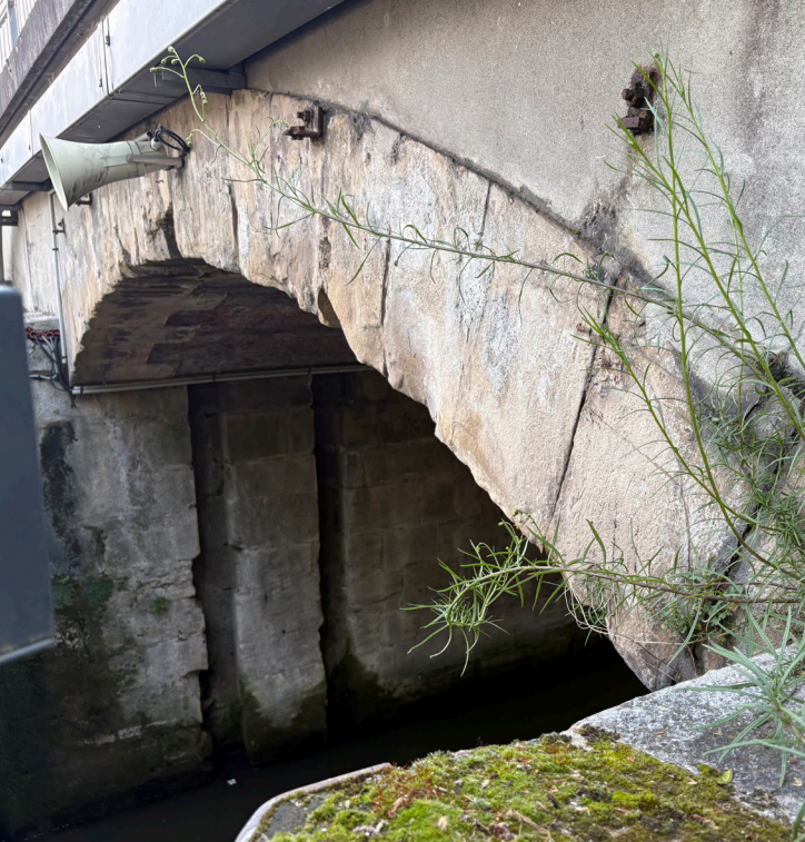
Vue du pont côté écluse. Le pont XIXe vient se greffer sur le mur de fuite de l'écluse - on remarque les batardeaux servant à son assèchement
