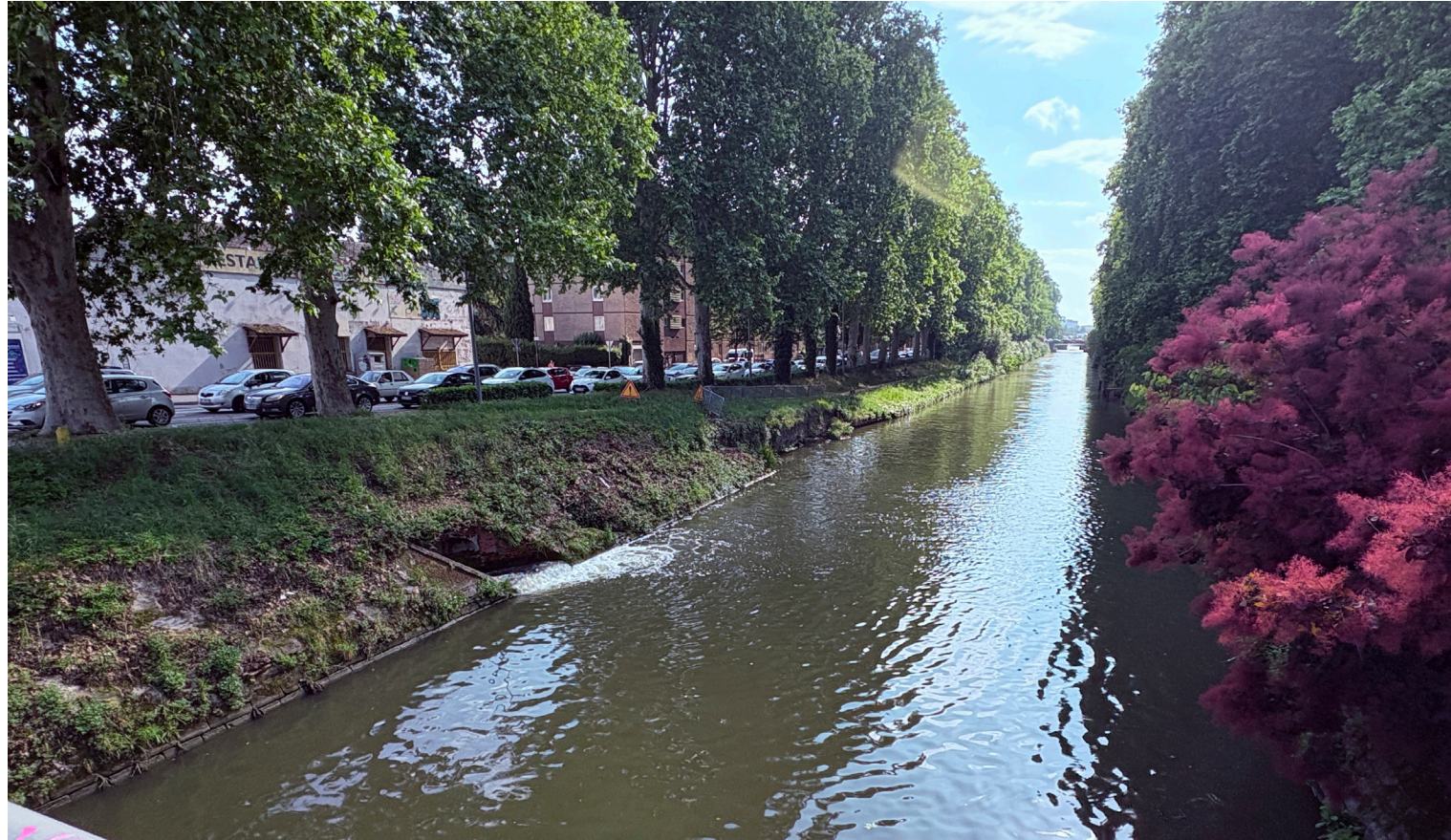
Vue générale de la berge de la Marquette depuis le pont du Béarnais. La berge est érodée au droit de l'interruption de l'ancien perré pour aménager un quai à la deuxième moitié du XIXe. La maçonnerie de support de l'ancien ponton de chargement en bois est de tout venant, lessivée, elle bascule dans le canal. Elle s'est partiellement écroulée dans ce dernier.
