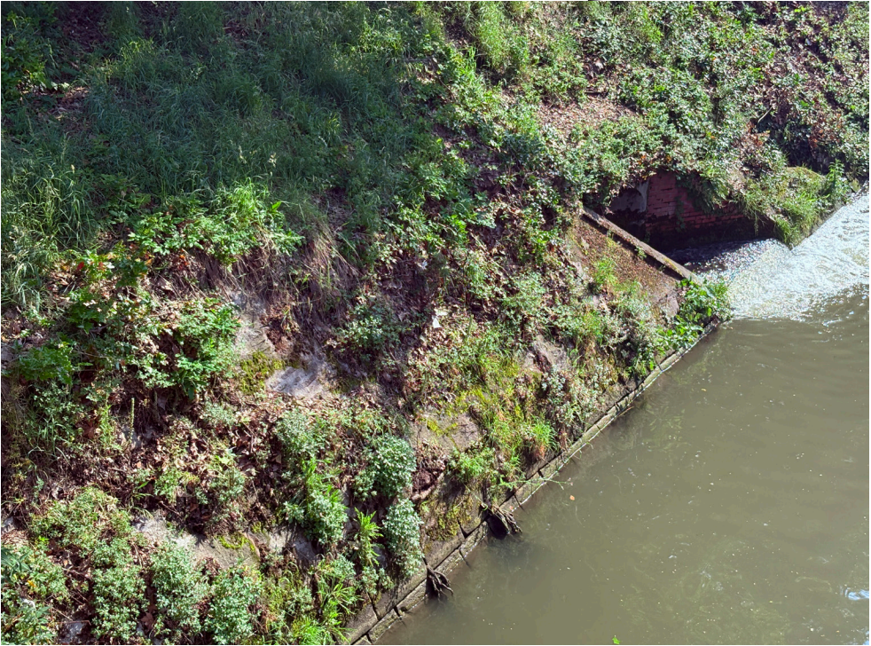
Vue de détail du mur de soutènement ancien. Il est toujours en place même si masqué par la végétation, il conserve des parties en moellons de pierre (en bas, des reprises ciment, des reprises en brique foraine), on note l'aménagement de la sortie de dérivation busée lors des travaux sur le pont.
