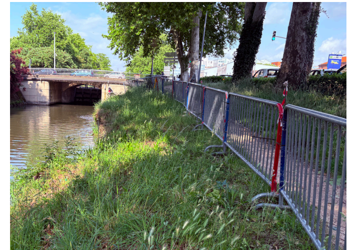
Ravinement au droit du chemin de contre-halage - barrières de sécurité pour éviter des chutes accidentelles
