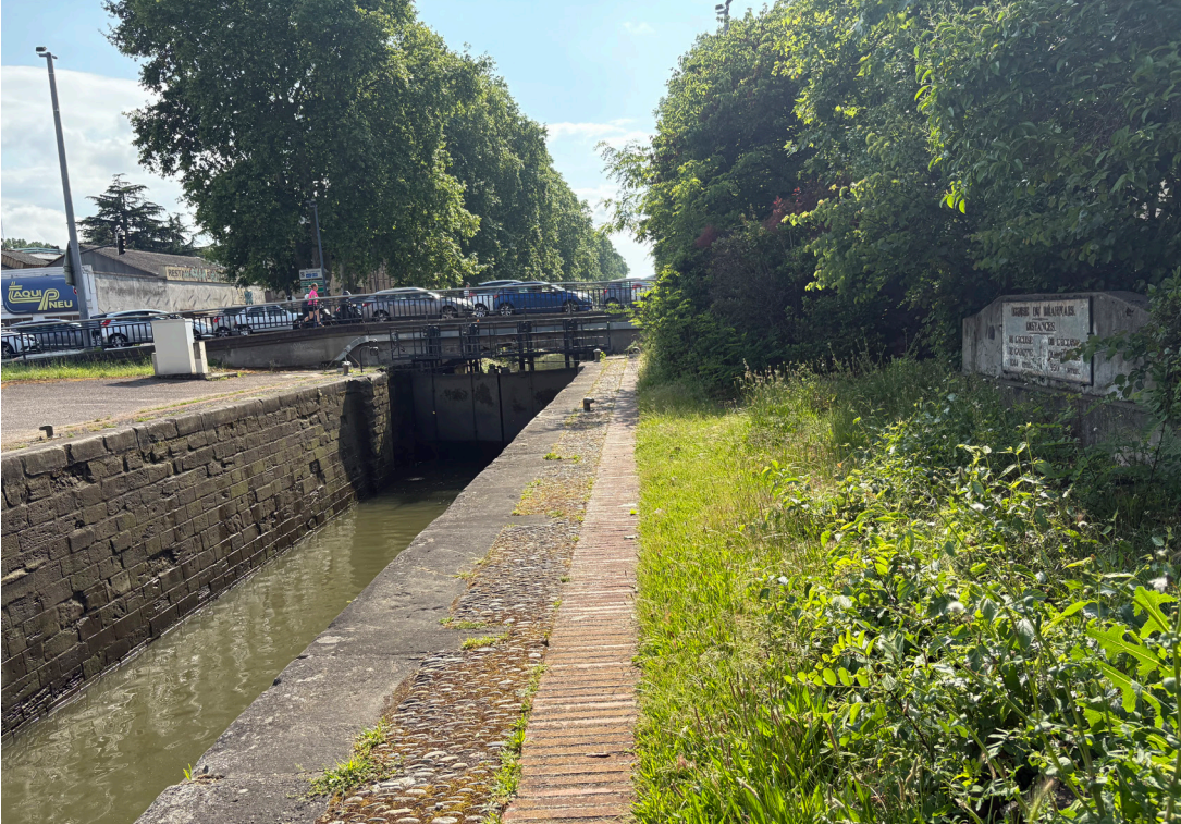
Vue générale des maçonneries XVIIe de l'écluse (construite en 1667 et reprise en 1670 puis au XIXe). A droite seule la plaque de l'ancienne maison éclusière est conservée à l'emplacement de celle-ci
