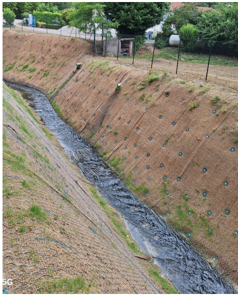
Exemple de retenue des terres, maintenues par un système GRIPPLE (tirant d'ancrage + grillage et toile de coco). Solution permettant une végétalisation rapide du talus - photos d'exemple à Lascardos
