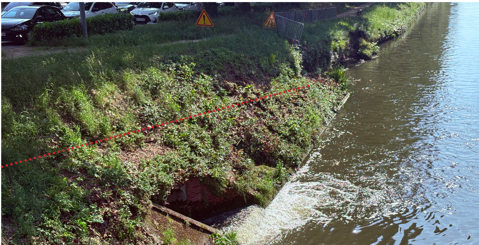
3. Vue depuis le pont vers le raccord entre l'aile maçonnée fin XVIIIe et le quai aménagé au milieu XIXe. Les maçonneries plus tardives sont de mauvaise qualité ne tenant pas aux poussées des terres. Ci-contre détail du raccord entre les deux maçonneries.
