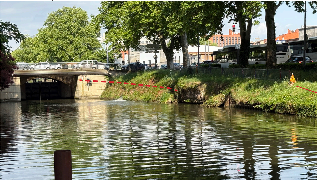
Identification du soutènement ancien du chemin de contre-halage côté bv. de la Marquette qui se prolonge sous l'extension moderne du pont.
