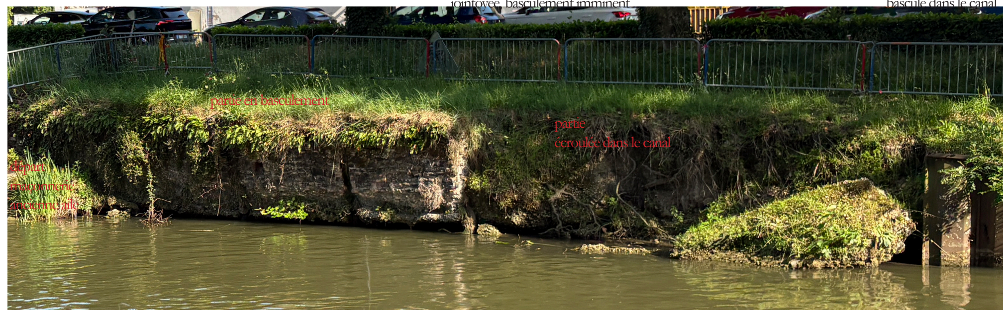
maçonnerie en dévers, fissurée et dé-jointoyée, basculement imminent
